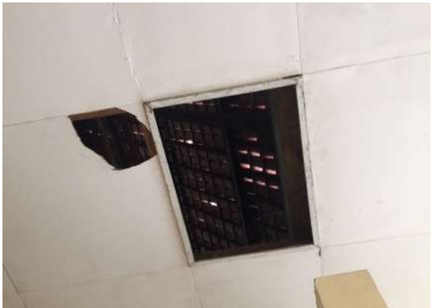
Gambar 4. Pecahnya asbes di lt4. FPSB
