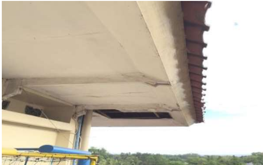
Gambar 2. Terdapat lubang besar di asbes sayap terluar Fakultas
